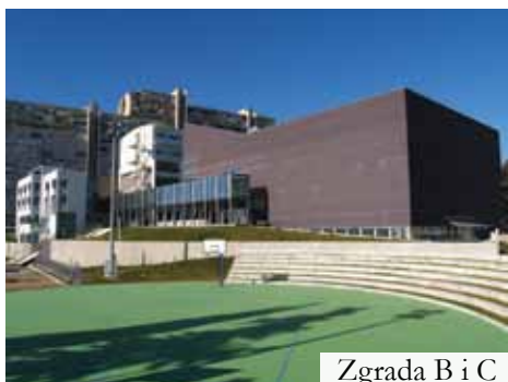
Zgrada B i C
