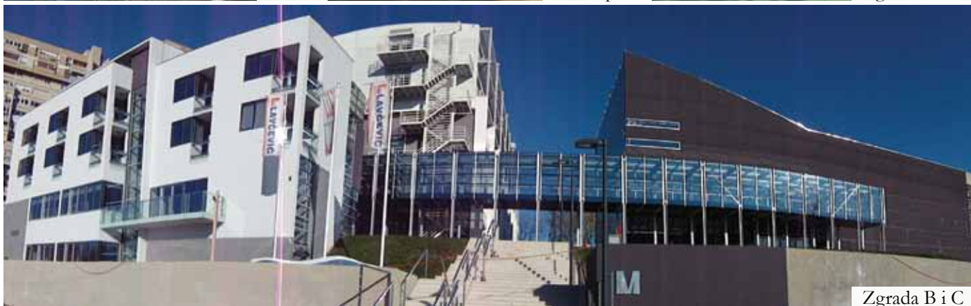
Zgrada B i C
