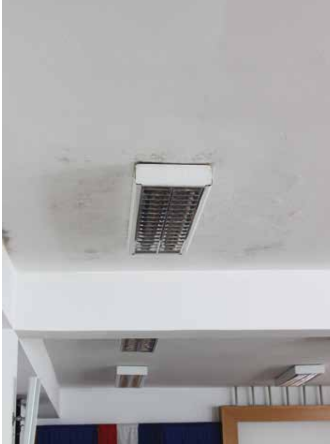
» Strop i rasvjetno tijelo u velikoj predavaonici
